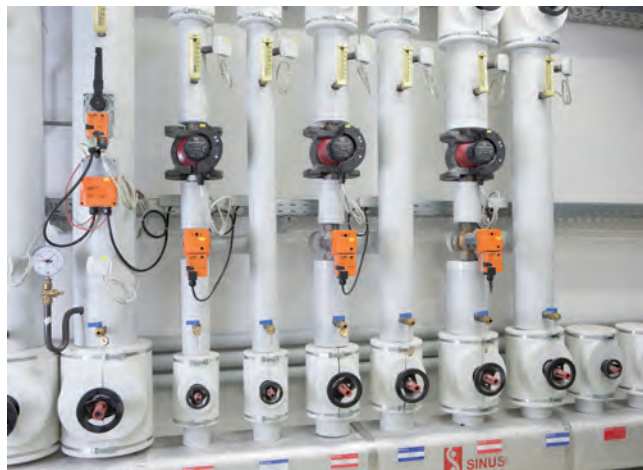
Die Energieventile sorgen auch für eine geregelte Kälteverteilung. Aktuell sind 38 Belimo Energy Valves (DN 25 bis DN 100) in allen wichtigen Bereichen der Wärme- und Kälteversorgung installiert.
