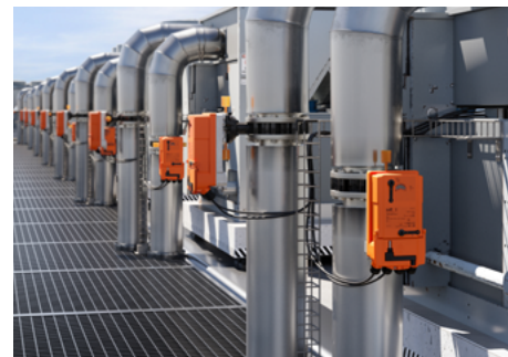
Válvulas Borboleta com Atuadores JR
