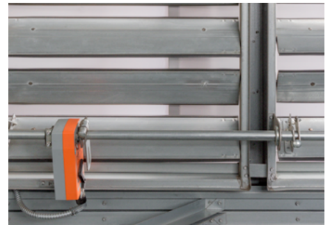
Servomoteurs à sûreté intégrée
